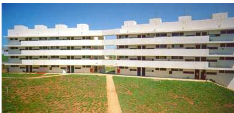
Fig. 4: Foto de fachada com a galeria (CAMARGO, 2000, p. 94)
