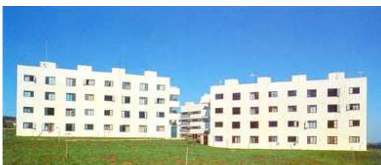
Fig. 5: Foto de fachada com aberturas (CAMARGO, 2000, p. 94)
