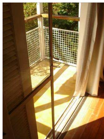
Figuras 14 e 15 – Vidros escurecidos e varanda interna garantindo proteção à radiação solar direta e ofuscamento nas salas de estar do terceiro pavimento
