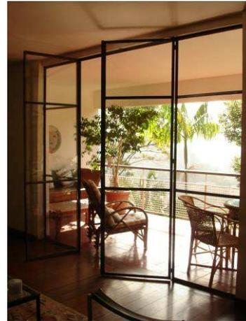
Figuras 08 e 09 – Vidros escurecidos e varanda interna garantindo proteção à radiação solar direta e ofuscamento nas salas de estar do terceiro pavimento
