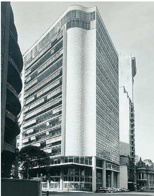
M.M. Roberto. Edifício Seguradoras . 1949
