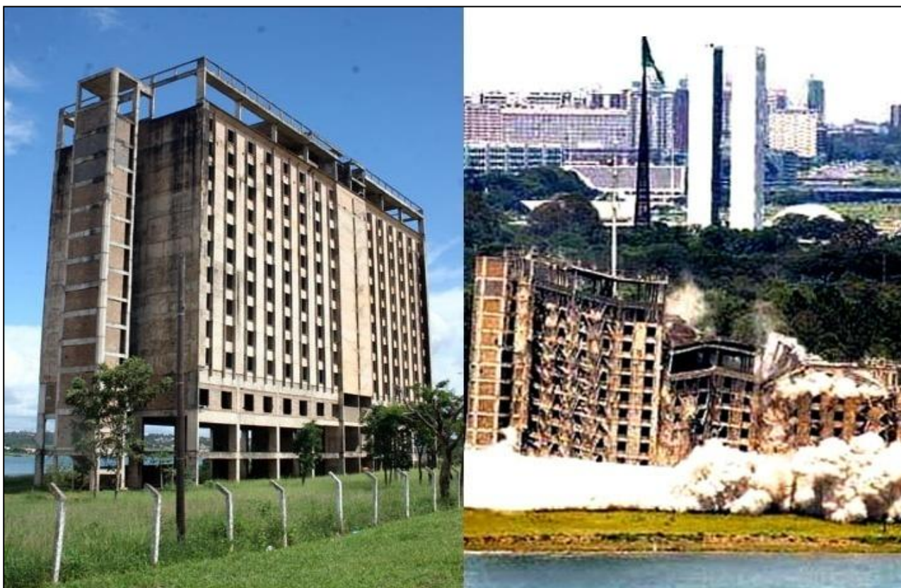
Figure 4 – À esquerda Hotel, abandonado e à direita o mesmo no momento de sua implosão.
