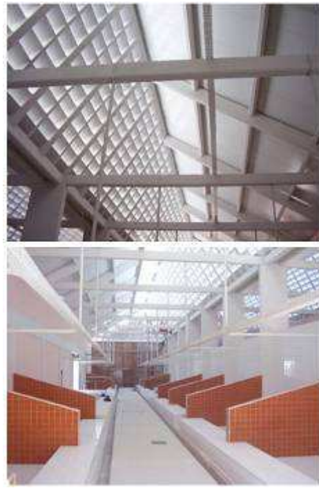
Fig. 9: Coberta e vista geral interna
