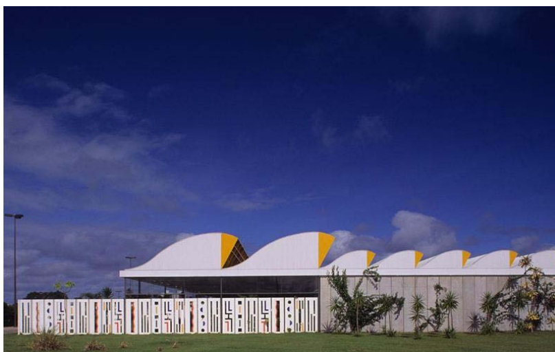
Figura 04: A arte de Athos dá vida ao muro vazado em argamassa armada do Sarah de Salvador. Imagem: Hugo Segawa
