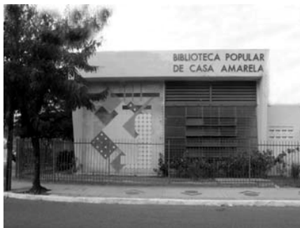
Figura 03: Biblioteca de Casa Amarela. 1952
