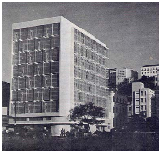
Figura 2 – Edifício Caramuru – fachadas voltadas ao poente 3
