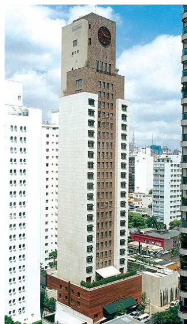
Figura 9 – Fachada do Fasano
