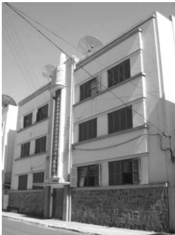
Fig. 3: Edifício Santo Antônio, Santo Ângelo-RS (Foto: Rodrigo Fabricio Kerber)
