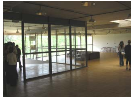
Figura 17: Esquema tema base (em branco) e tema destaque (em cinza) da obra. Figura 18: Saguão e acesso do alojamento. Fontes: Arquivo autor
