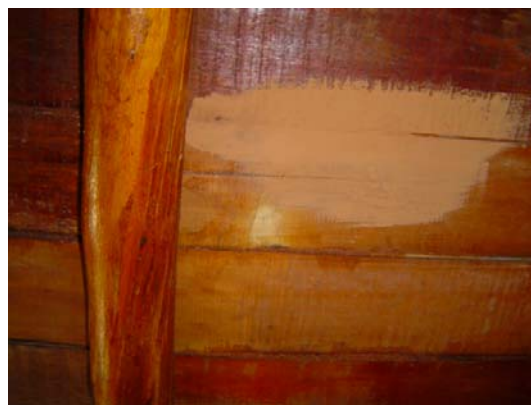
2) reparos na madeira
