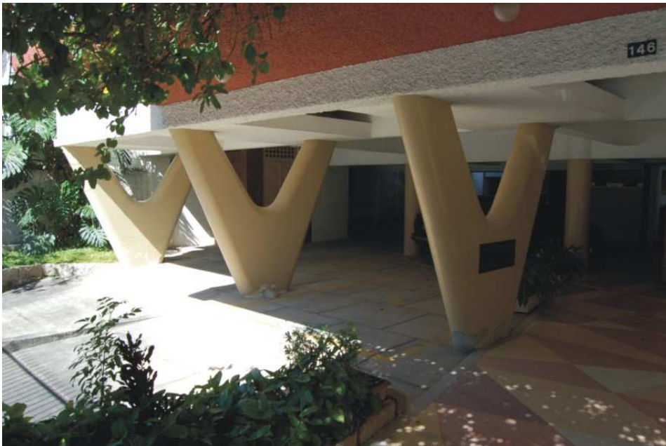
Figura 5: Edifício Mussi: detalhe dos pilotis em "v". Fonte: Dario de Almeida Prado, 2008.
