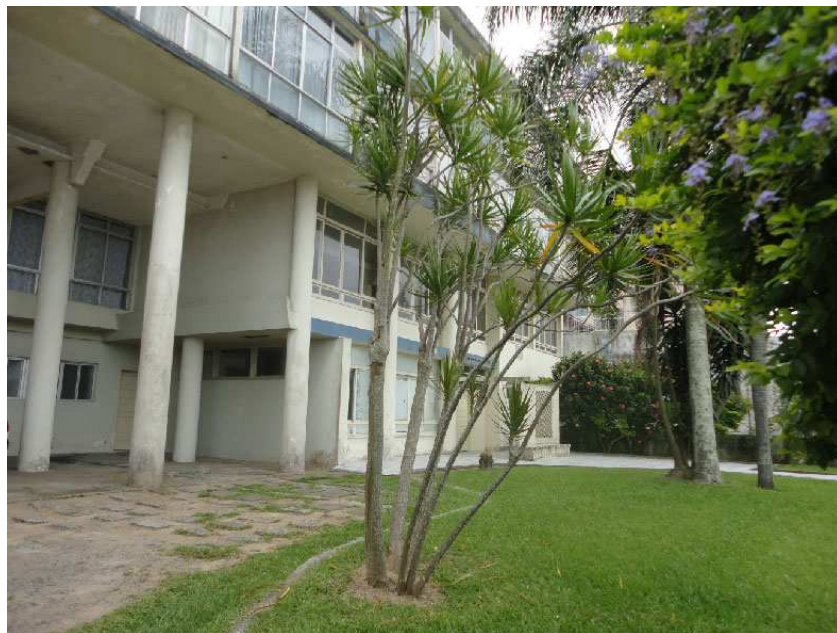
Figura 8: Edifício Normandie: detalhe da fachada e pilotis. Fonte: Marina Cañas Martins, 2011.
