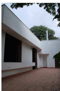
Fig.4. Terraço norte com caixilhos embutidos, maio de 2008 (foto da autora)
