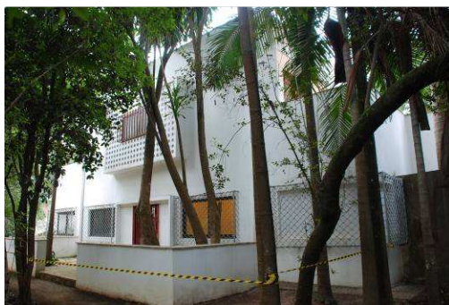
Fig.1. Fachada sul em maio de 2008 (Foto da autora)
