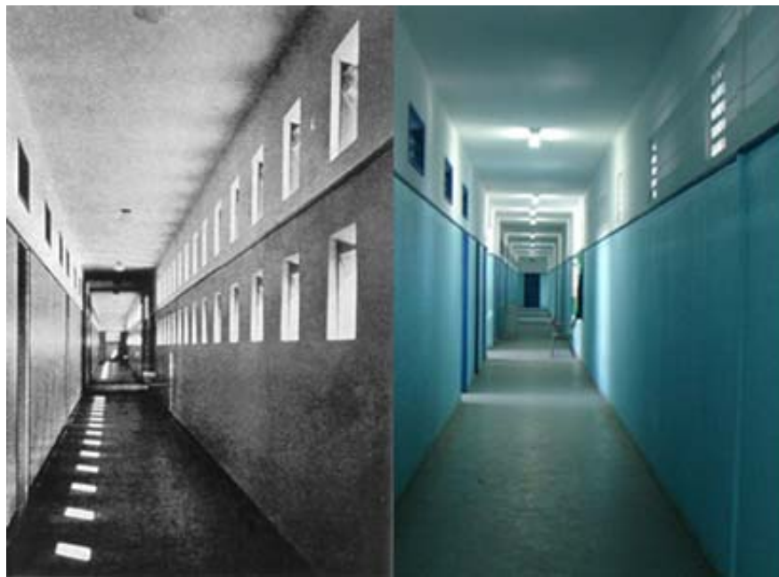
Fig. 8 – Comparação corredor interno original e corredor interno após a obra e fechamento das janelas – Fonte: Conduru, 2000 e Foto Cinthia Serrano, 2007
