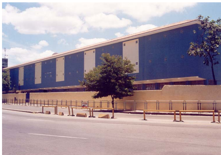
Fig. 5 – Inauguração da Obra – Fonte: Arquivo do Colégio Estadual Raul Vidal, 2004.
