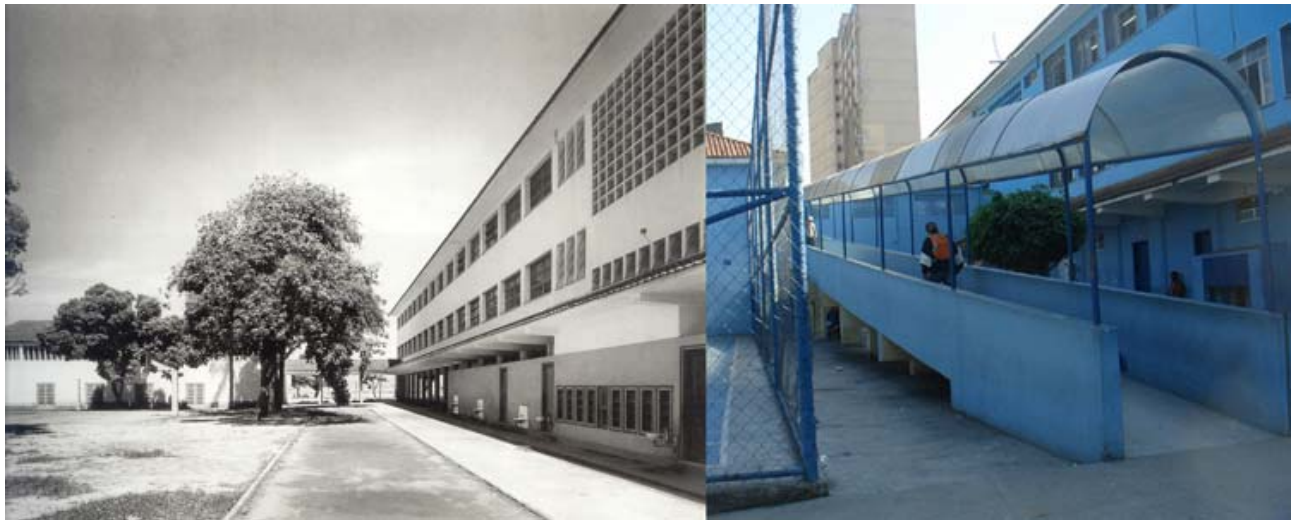
Fig. 7 – Comparação Fachada interna original e Fachada após a obra e implementação da rampa – Fonte: Conduru, 2000 e Foto Cinthia Serrano, 2007.
