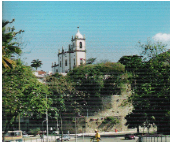
Figura 4: vista do acesso atual a Igreja.
