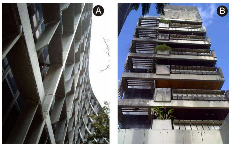
FIGURA 5: A- CELPE, Vital e Reginaldo Esteves, 1972; B- Edifício Itaoca, Dinauro Esteves & Luiz Priori, 1976.
