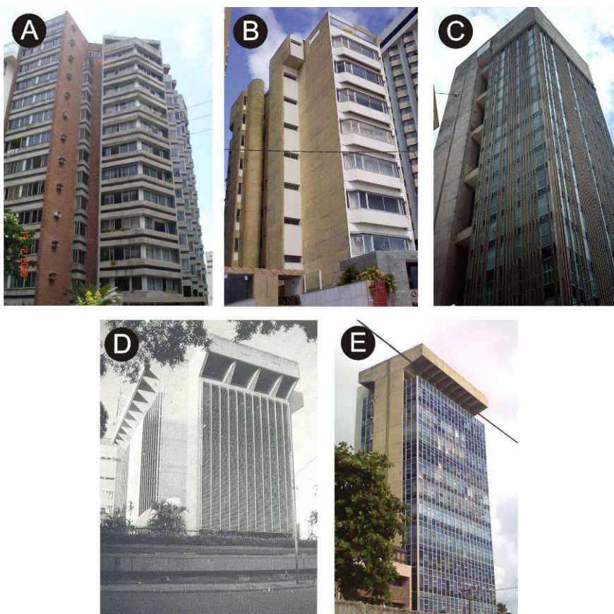
FIGURA 4: A- Edifício Mirage, Borsoi, 1967; B- Edifício Oásis, Glauco Campello, 1970; C- BANDEPE, Borsoi e equipe, 1968. D- IBM, Jeronimo e Pontual, 1970-1; E- Sparta, Jeronimo e Pontual, 1972. Foto 'D' de autoria de Geraldo Gomes, demais fotos dos autores.
