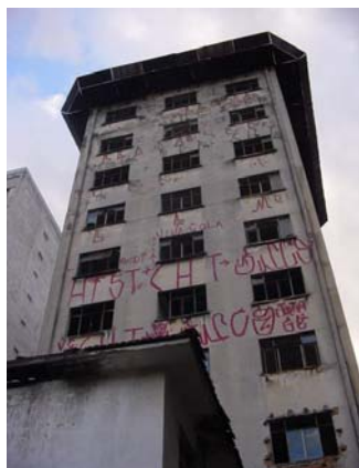
Foto 1. Fachada do Edifício Brigadeiro Tobias antes da intervenção Fonte: Integra, 2002
