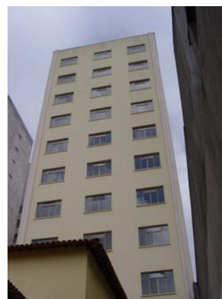
Foto 2. Fachada do Edifício Brigadeiro Tobias após a intervenção (Salcedo, 2006)
