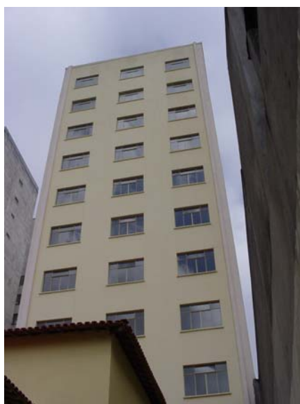
Foto 3. Edifício Brigadeiro Tobias
