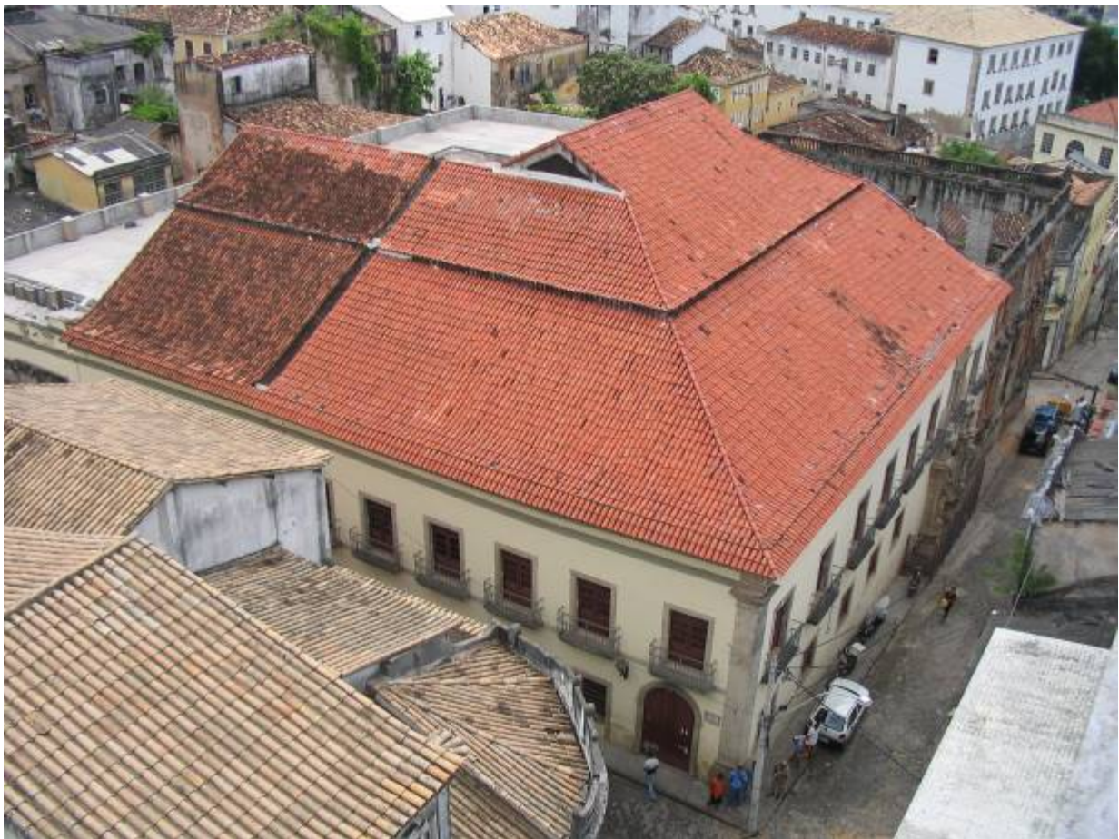
Figura 14 – Vista geral do Paço do Saldanha após a intervenção realizada por Diógenes Rebouças e Prado Valladares Arquitetos S/C (Foto realizada pelos autores, dez./2004)
