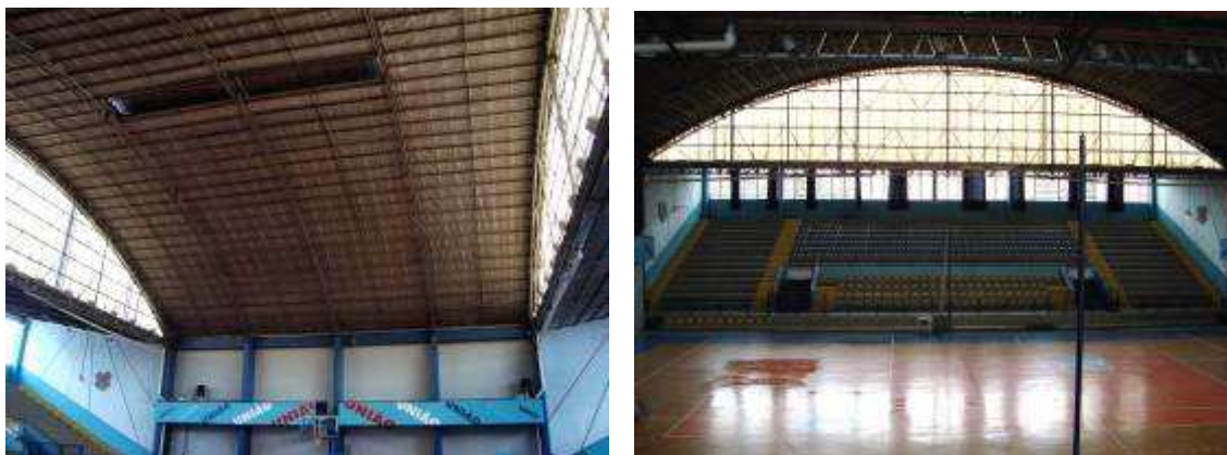
Figs. 6 e 7: Interior, segundo pavimento. (Foto: Autoras)
