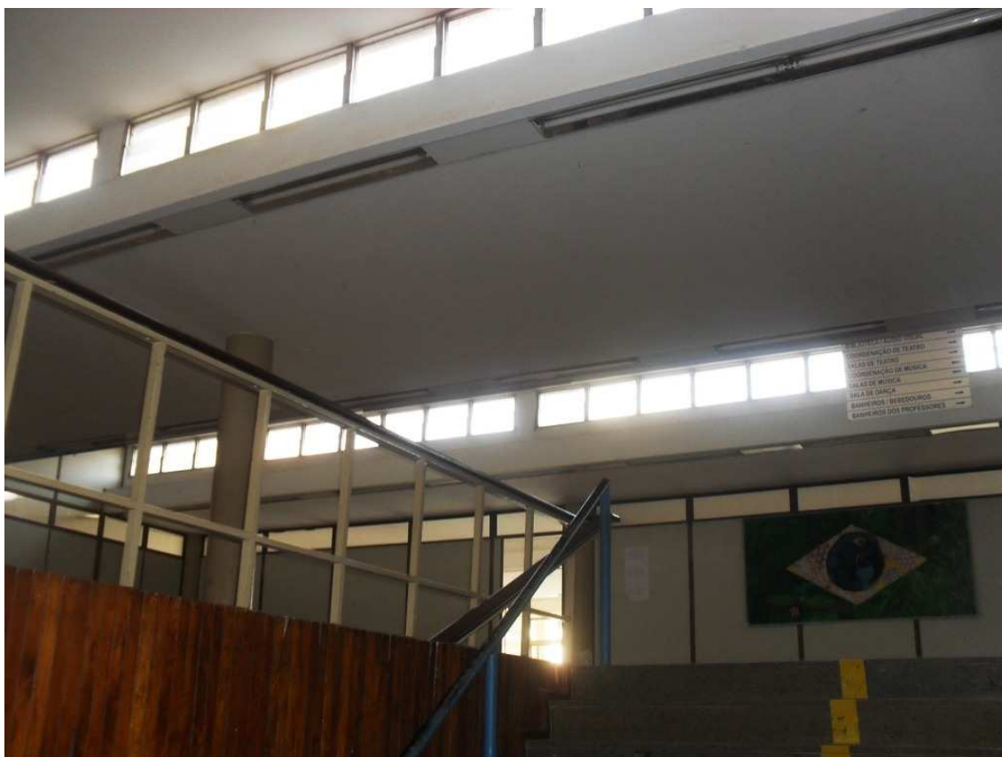
Fig. 5: interior do bloco principal da Escola-Parque 307/308 Sul (Foto: autor).
