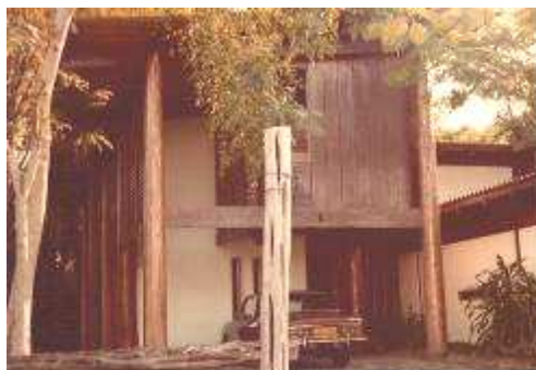
Fig. 11: Residência do arquiteto, Manaus, 1971, arq. Severiano Porto. (Fonte: Arquivo Severiano Porto).
