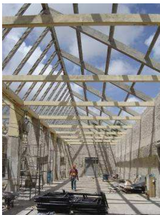
Fig. 7: Obra em andamento (interior)
