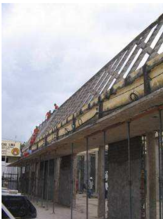
Fig. 6: Obra em andamento (exterior)
