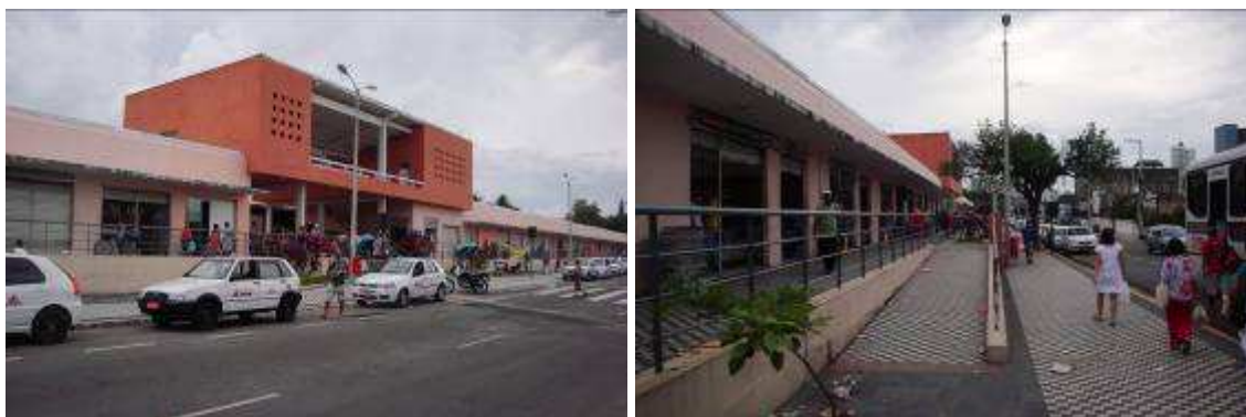
Fig. 13: A partir da retirada das barracas a fachada do mercado se tornou visível à população. Foi possível organizar os passeios, os elementos de acessibilidade e ampliar a cobertura vegetal numa área caracterizada pela aridez.
