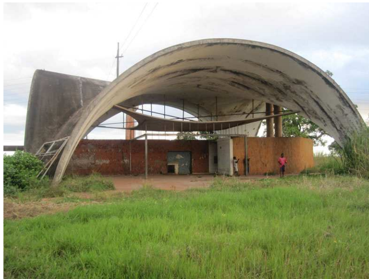
Fig. 9 Arménio Losa e Cassiano Barbosa, Fábrica Monteiro&Giro , Muirua, Quelimane, 1956-1958. Foto: Maria Manuel Oliveira.
