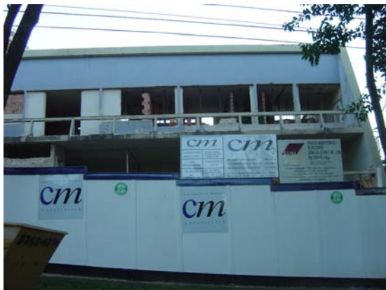
Figura 6: Edificação localizada à Rua Sinval de Sá, 422, Cidade Jardim.
