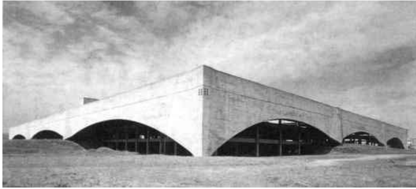
Figura 8: Hospital Escola Santa Casa de Misericórdia, atual Fórum criminal de São Paulo ( Fábio Penteadó: Ensaios de Arquitetura, 1998 )
